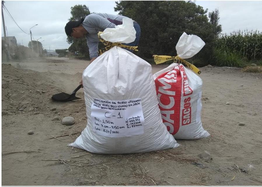
Figura 97, Se observa el momento en que el personal del laboratorio INGELCI SAC PERU tapa la calicata C-1
