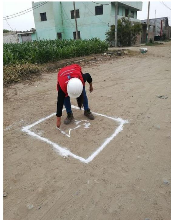
Figura 92, Se observa la C-1 con medidas de 1.2 m x 1.2 m x 1.5 m
