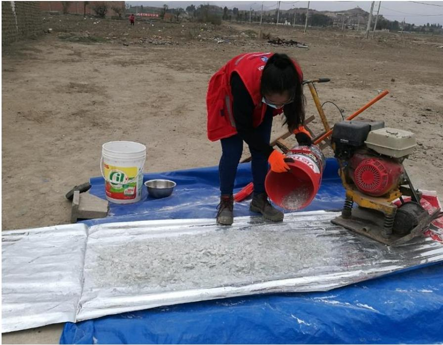
Figura 81, Se observa el baseado del vidrio para otra pasada con la plancha compactado
