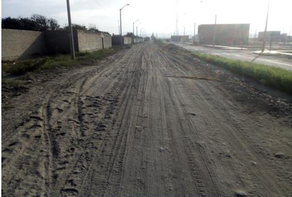
Figura 70, Se observa la condición (polvadera) y el desnivel de la vía perteneciente al tramo final
