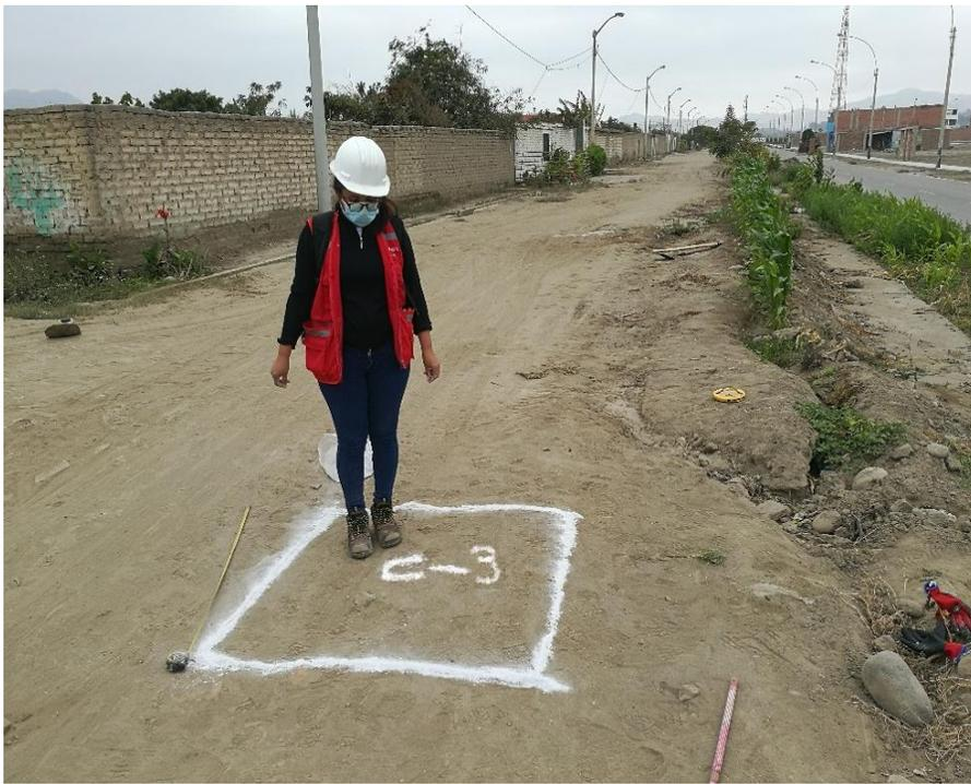
Figura 104, Se observa la calicata C-3 con medidas de 1.2 m x 1.2 m x 1.5 m
