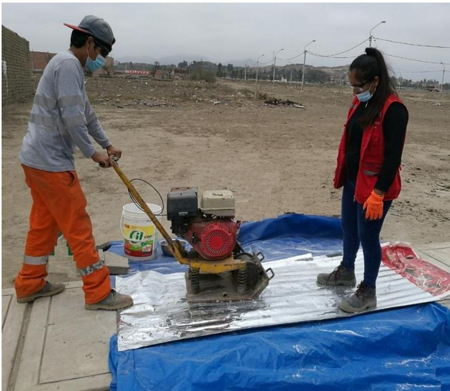
Figura 80, Se observa el momento en que se tritura las botellas con la plancha compactadora
