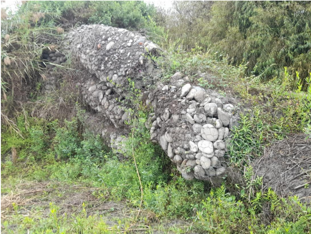
Gaviones existente N° 1.
