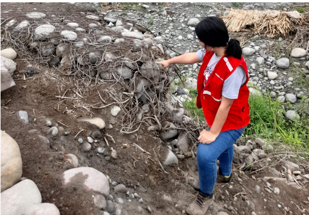
Gaviones existente N° 2.
