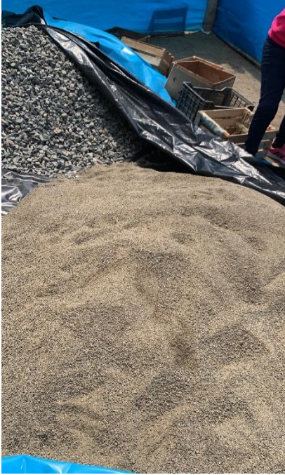
Agregado fino y grueso para poder hacer el concreto en obra.
