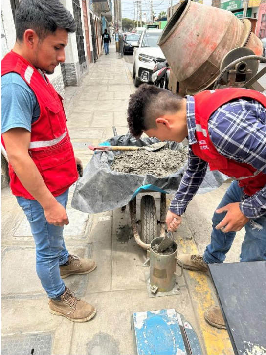
Ensayo del peso unitario del concreto.
