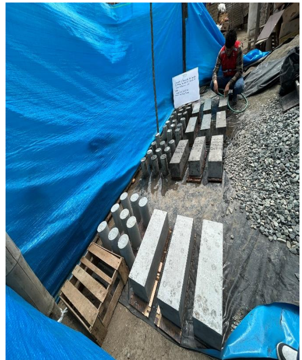
Curado de los especímenes del concreto.
