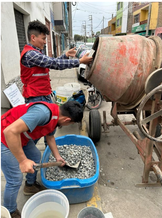
Mezclado de concreto
