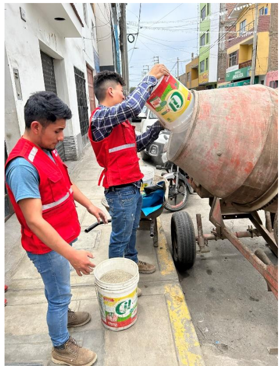
Mezclado de concreto
