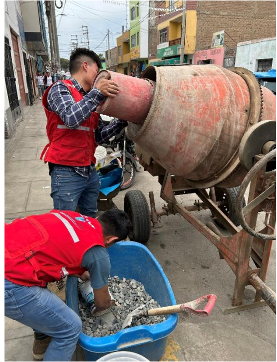
Mezclado de concreto
