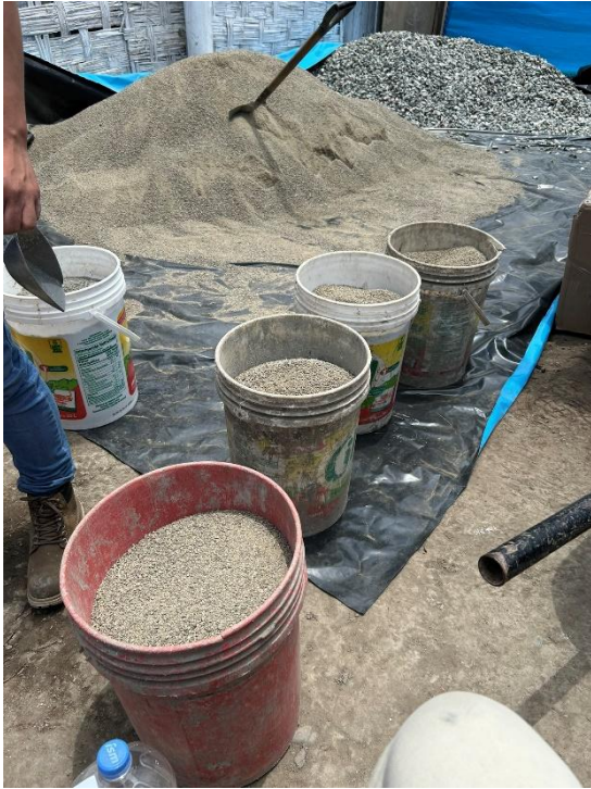
Insumos para la preparación del concreto
