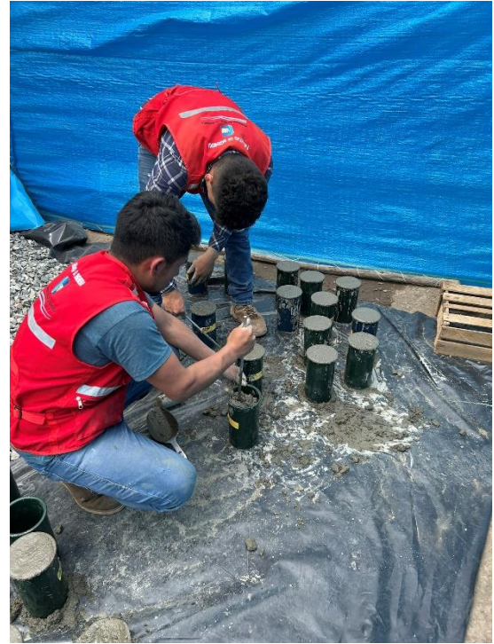
Colocado del concreto en los moldes Cilíndricos
