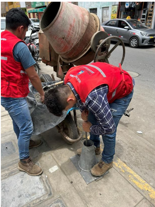
Ensayo del asentamiento del concreto.
