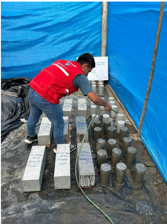
Curado de los especímenes del concreto.
