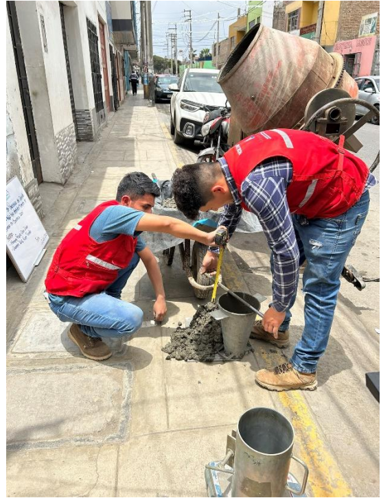
Ensayo del asentamiento del concreto.
