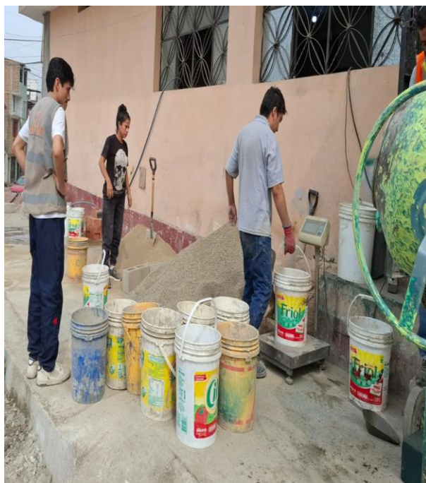
Foto 15: Medición de materiales según la dosificación.
