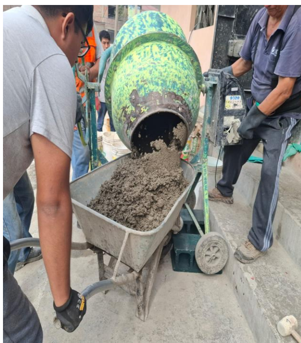
Foto 16: Mezcla de concreto del diseño Patrón.
