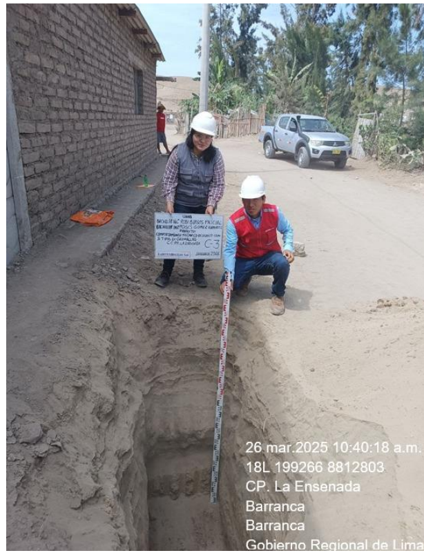
Foto 04: Ubicación de Calicata N° 3.
