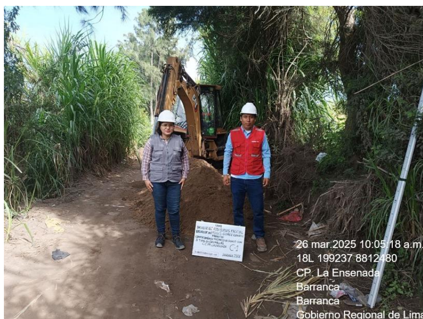
Foto 2: Ubicación de Calicata N° 1.
