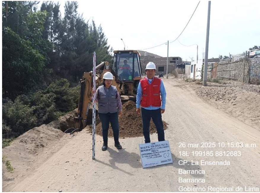
Foto 3: Ubicación de Calicata N° 2.
