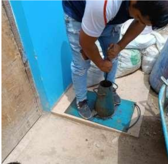
Foto 29: Se realizó el ensayo de asentamiento.
