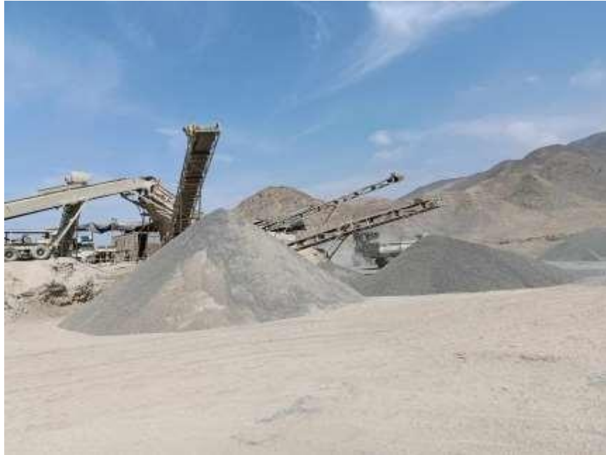
Foto 3: Cantera Acaray Constructora Bitumen..
