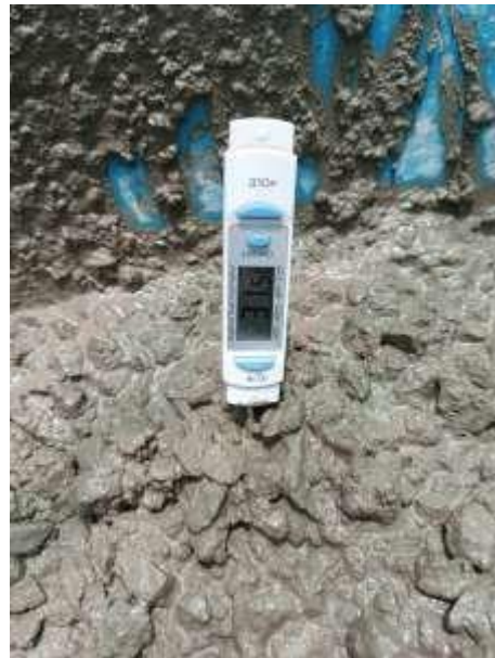
Foto 24: Verificación de temperatura del concreto patrón según NTP 339.114
