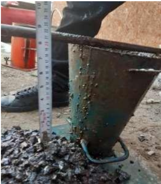
Foto 31: Se realizó la medición del asentamiento del concreto polimérico.
