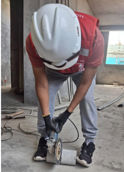
Foto 87: Corte de probetas para los ensayos de densidad, absorción y vacíos en concreto endurecido.
