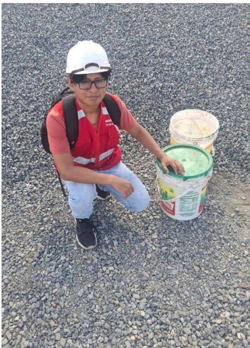
Foto 07: Extracción del agregado grueso de la cantera “Rio Seco”.
