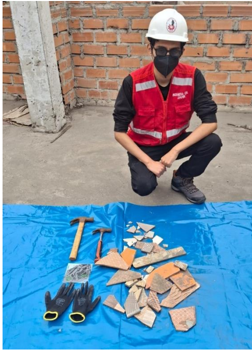
Foto 47: Equipos a utilizar para reducir el tamaño de los residuos cerámicos.
