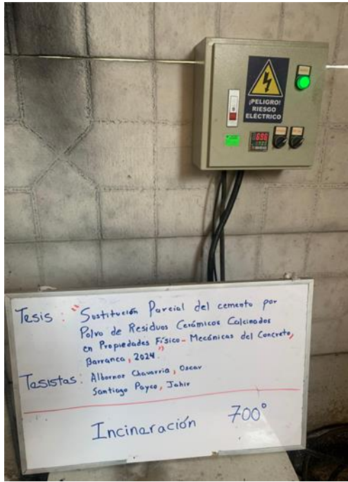
Foto 57: Incineración a 700° del polvo de residuos cerámicos.
