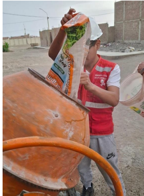
Foto 40: Elaboración del concreto patrón.
